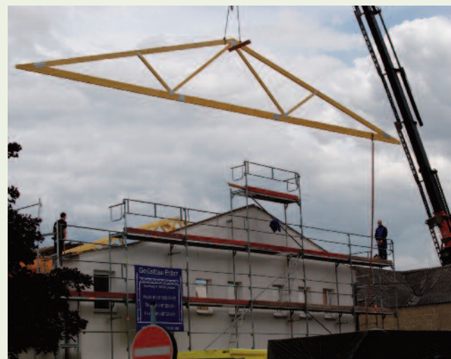
Ein neuer Nagelbinder wird zum Einbau auf das Dach transportiert
