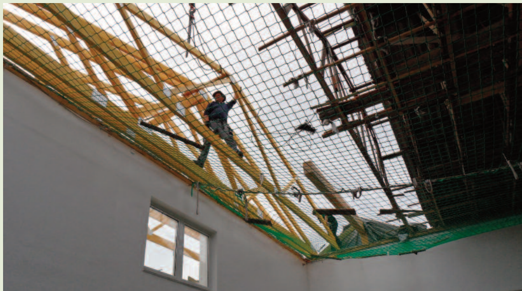
Die ersten Nagelbinder des neuen Daches der TSV-Turnhalle werden ausgetauscht
